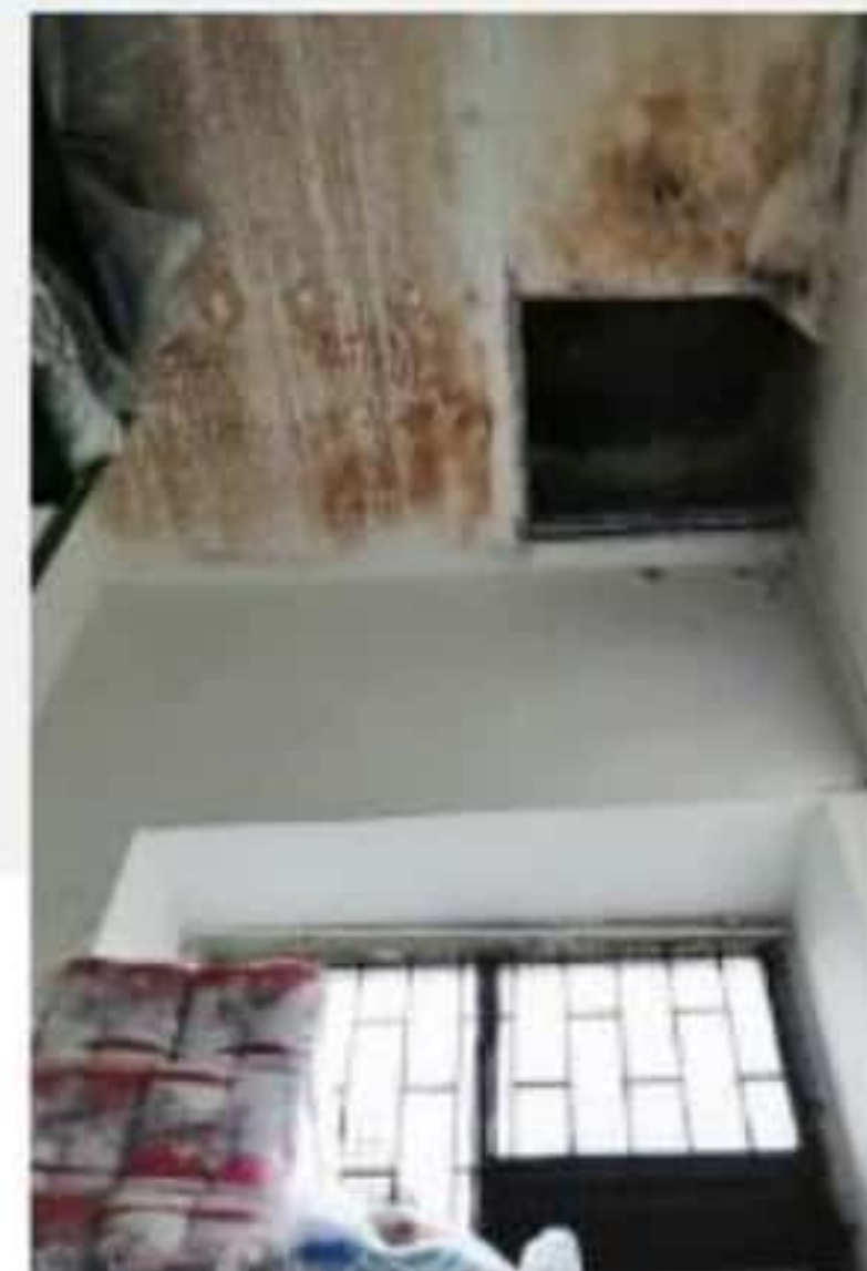
[4] Bodega - Calle 72, Edificio P
