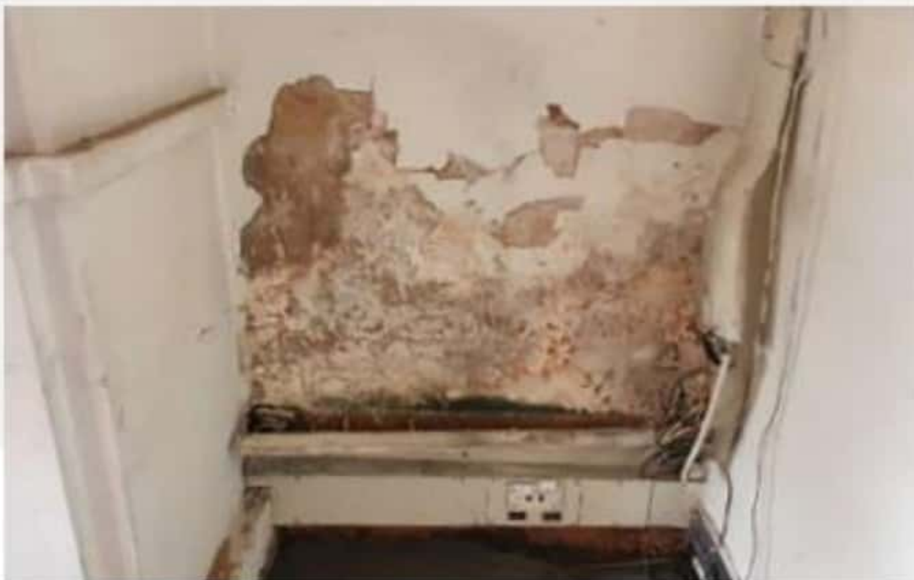
[16] Redes con presencia de humedad
