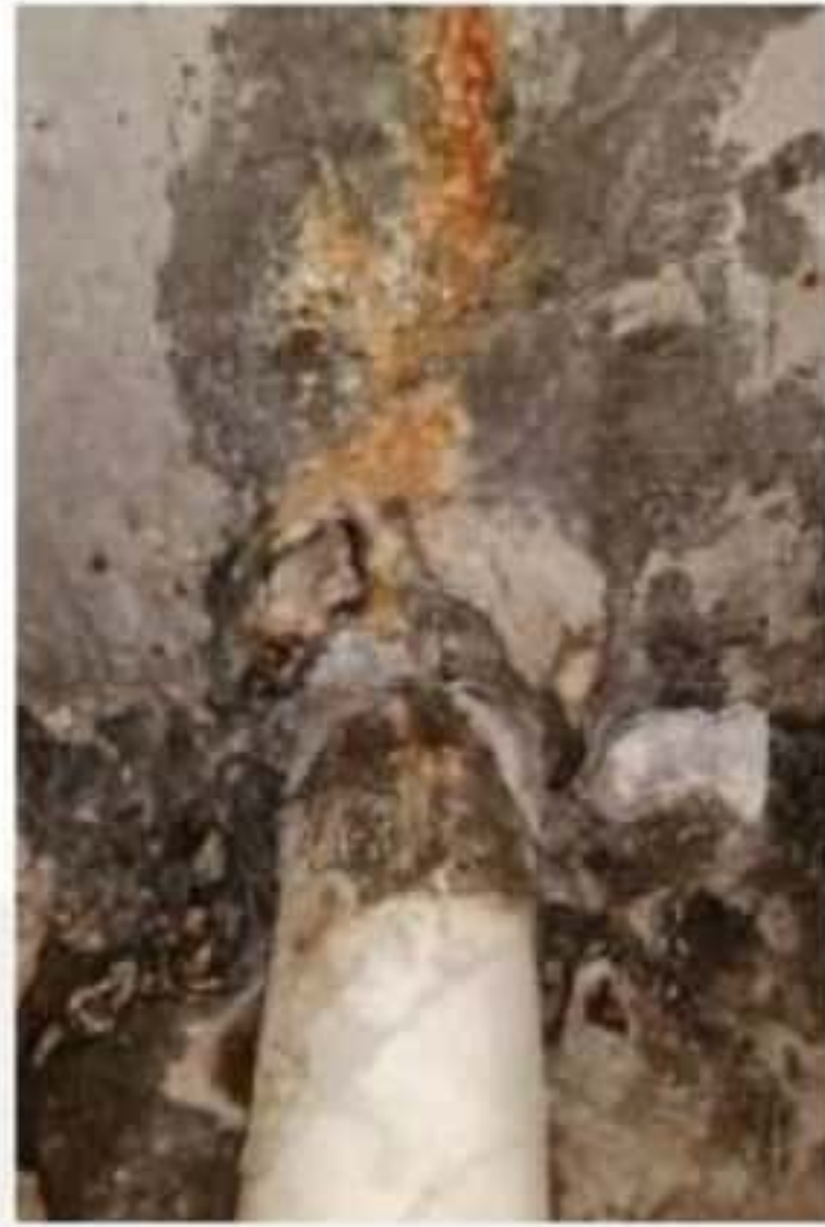
[8] Tubería al aire
