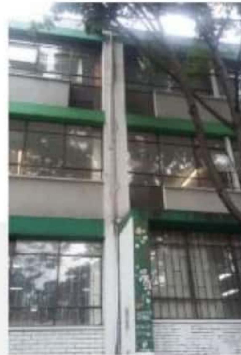
[2] Fachada Edificio A
