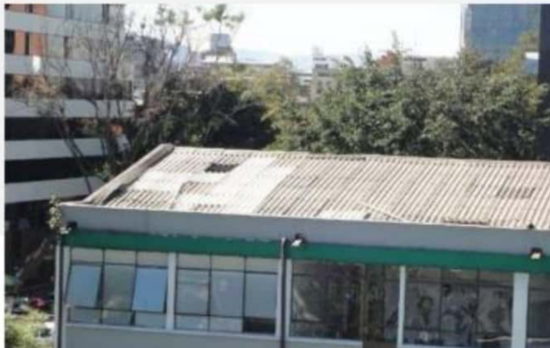
[19] Cubierta Edificio C y E
